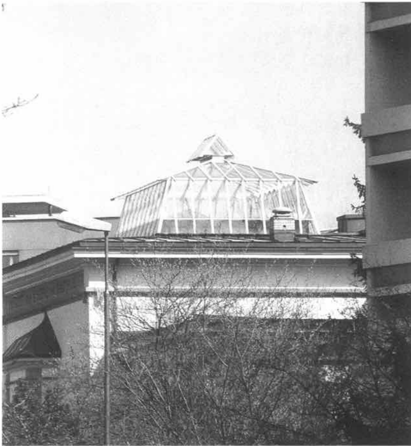
Friedbühlstrasse 51: Neue Glaslaterne auf dem ehemaligen Auditorium.
