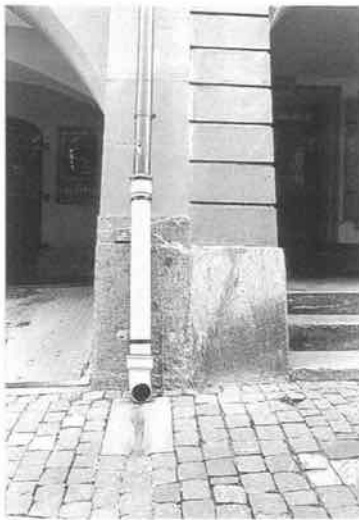
Pflasterung Junkerngasse/ Kreuzgasse: Detail der Neupflasterung mit einer der vier wiederher- gestellten offenen Dach- entwässerungen der Schatt- seite der Junkerngasse.
