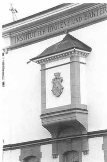
Friedbühlstrasse 51: Erker mit Wappen an der Fassade des ehemaligen Auditoriums.
