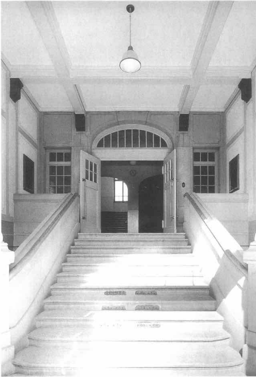
Bitziusstrasse 15: Die restaurierte, ursprünglich offene Eingangshalle.
