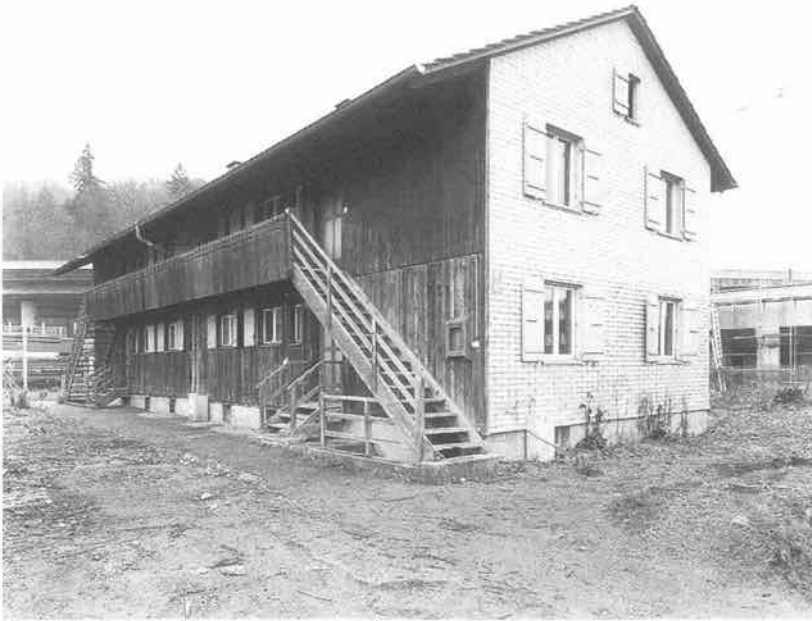
Wangenstrasse 95/97: Abbruch der letzten so genannten Export-Häuser.
