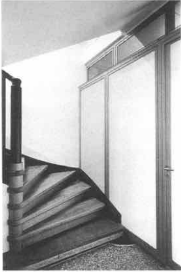
Alpeneggstrasse 14: Umgebaute originale Eichentreppe mit neuem Wohnungsabschluss im Erdgeschoss.
