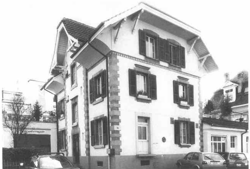
Weissenbühlweg 44: Ehemaliges Wohnhaus vor dem Abbruch für die heutige Gesamtüberbauung.
