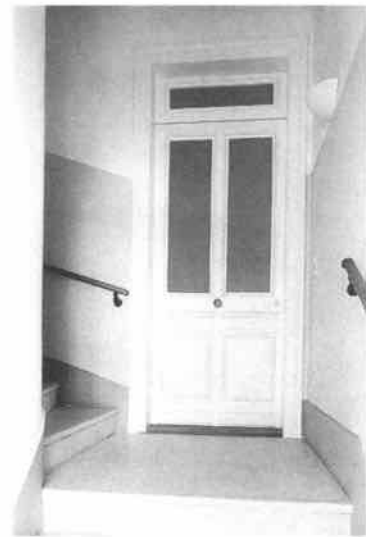
Rainmattstrasse 15: Wohnungseingang im ersten Obergeschoss mit einem der Bauzeit ent- sprechenden Türblatt aus dem Depot der Kantonalen Denkmalpflege.
