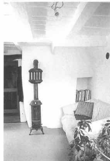
Alpeneggstrasse 10: Umgenutzte Küche im Südteil mit Etagen- holzfeuerung und ablesbar erhaltener Rauchbutte.
