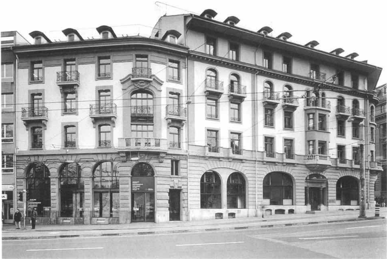
Bollwerk 27, 29: Die beiden Hauptfassaden.
