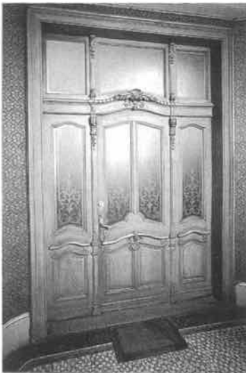
Thormann-Scheuer, Muristrasse 28: Wohnungsabschluss zum Vestibül.
