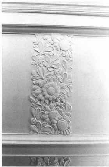
Bollwerk 27: Detail des Deckenstücks in der Bibliothek.
