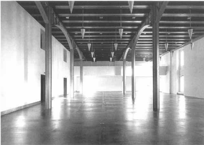
Kornhaus, Zeughausgasse 2: Stadtsaal nach dem Umbau mit der wieder freigestellten Stützenkonstruktion von 1895, neuer Galerie und restaurierter Balkendecke.
