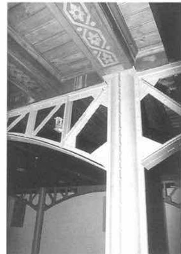
Zeughausgasse 2: Stützelement mit Fach- werkträger und bemalter Balkendecke.
