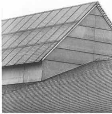
Depotstrasse 43: Firstoblicht mit in Glas eingegossener Fotovoltaikanlage.
