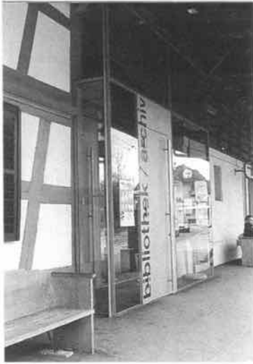
Bernstrasse 75–79: Neue Eingangspartie anstelle des alten Tennisors.
