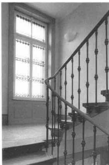
Sulgenbachstrasse 5: Treppenhaus mit restaurierter Marmorwandmalerei.
