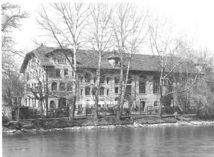
Dampfzentrale, Marzilistrasse 47: Aareseitige Fassadenansicht, vom Dalmaziquai aus aufgenommen.
