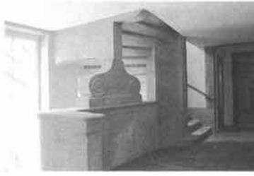
Junkerngasse 41: Stützkonstruktion am Über- gang der unterschiedlichen Treppengeometrien mit liegenden Voluten.
