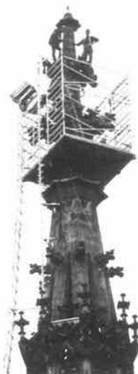
Berner Münster: Die Turmspitze während der Sicherungsarbeiten.
