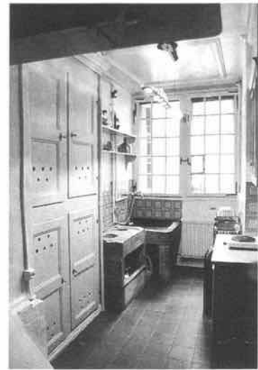
Junkerngasse 35: Küche mit Sandsteinherd und -ausguss sowie Ergänzung mit neuzeitlichen Apparaten.
