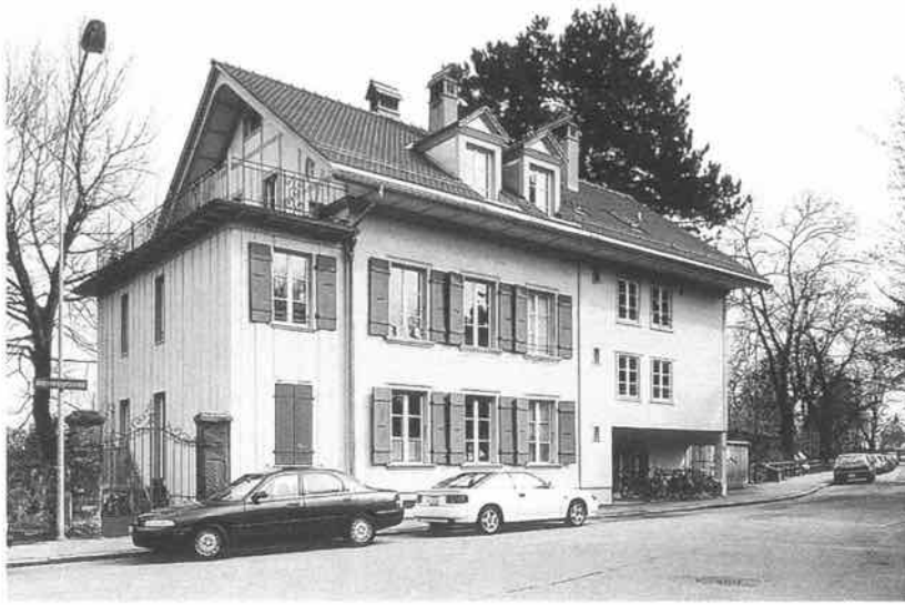
Alpeneggstrasse 10: Strassenansicht mit instand gestellter Fassade und wieder aufgebautem Dach mit Biberschwanzziegeln.
