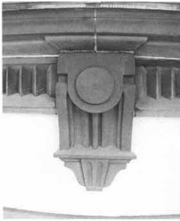
Lorrainestrasse 2: Konsole am Gurtgesims.
