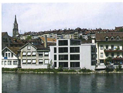
«Nahe am Wasser sollte man nicht bauen – wir tun es in der Berner Matte»: MFH mit Loft-Wohnungen von Spreng + Partner im Mattequartier.
